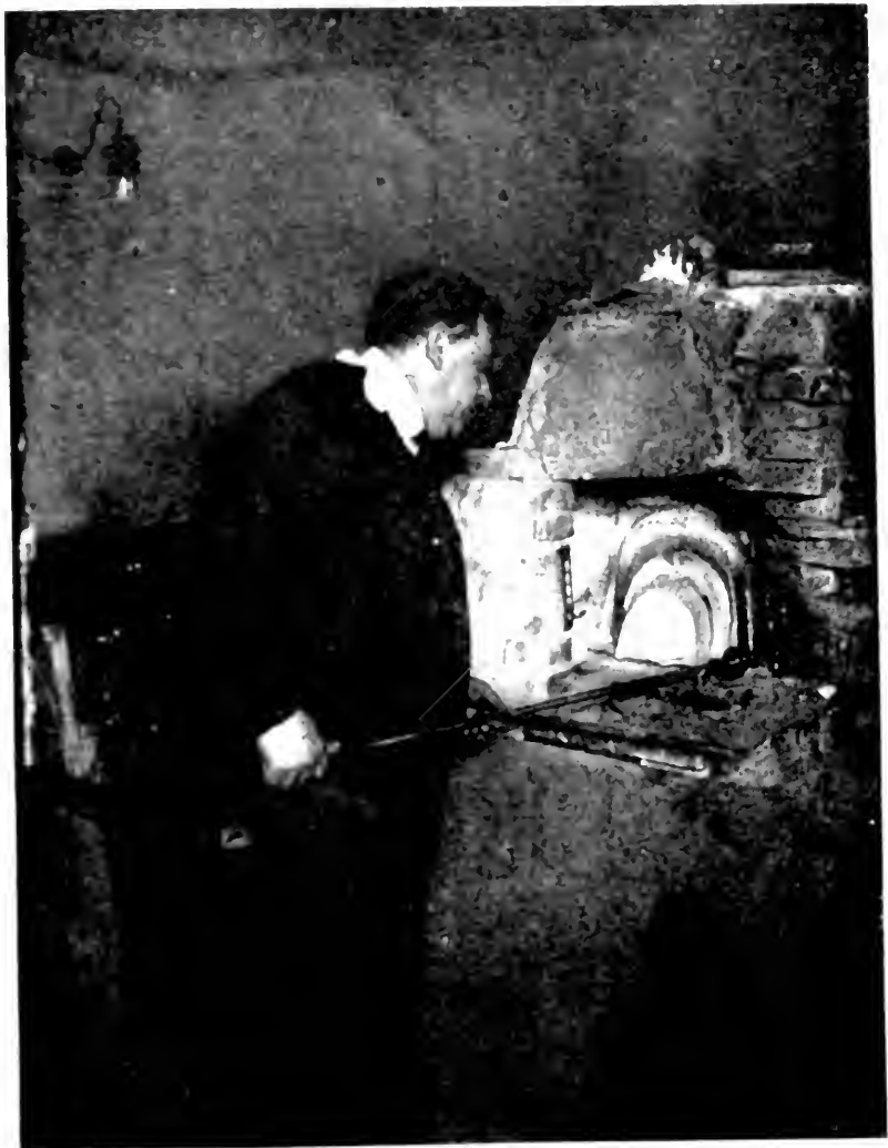
Fig. 10. — Le four à creuset pour la fusion du verre.
